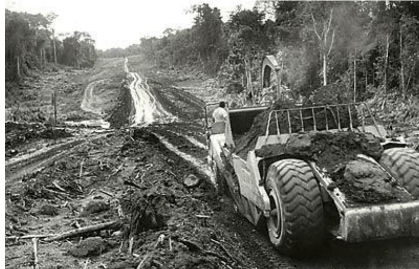
Figura 7. Maquinários fazendo derrubada e abertura para construção da Transamazônica em Altamira – PA em 1972. Fonte: https://flic.kr/p/RYorgb . Acesso em: 21 fev. 2022.
